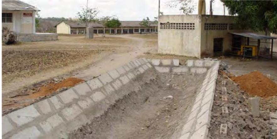
Illustration 7 : Exemple de tranchée pour renforcer la stabilité d'un digesteur préfabriqué [4]
