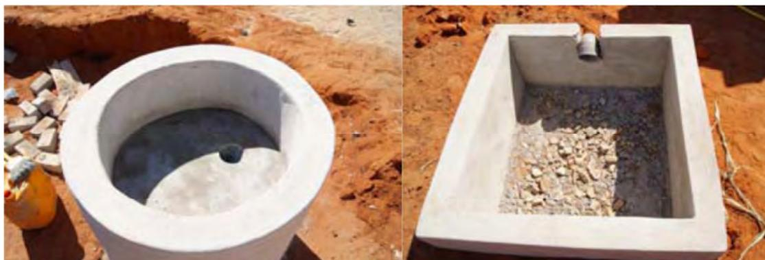
Illustration 13 : Exemple de bac d'alimentation du digesteur et d'évacuation du digestat
