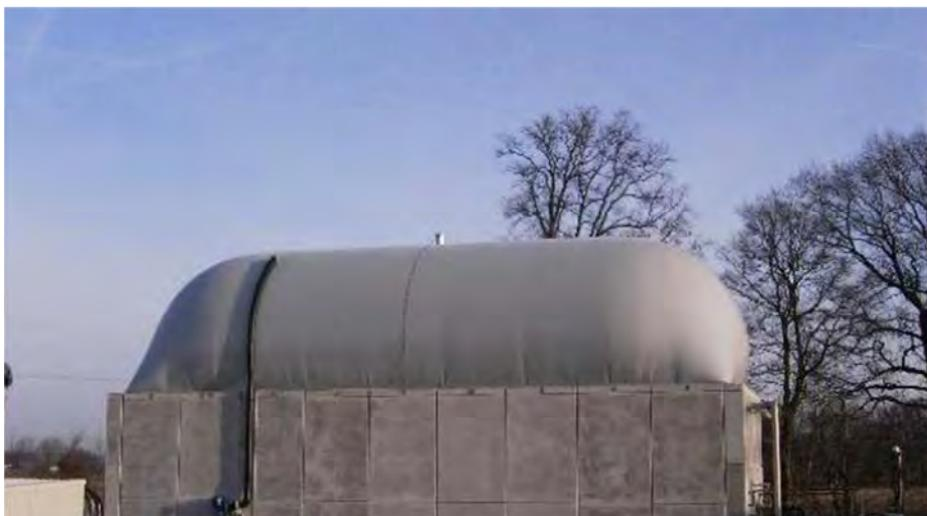
*Illustration 17 : Exemple de membrane de stockage intégrée au digesteur [Source : Ecothane]*
