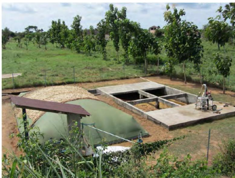
Illustration 6 : Digesteur fabriqué sur place et recouvert d'une membrane [6]
